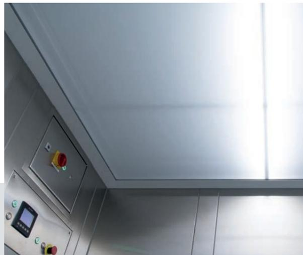
**!** CG-Verteiler sorgen für eine gleichmäßige Luftabströmung im Raum und sind optimal geeignet zur Erzeugung von Laminar-Flow-Bereichen innerhalb der Wiegekabine.
