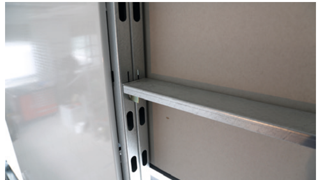
Labor- Wandsystem rechts offen mit Versteifung und links mit Panel abgedeckt
