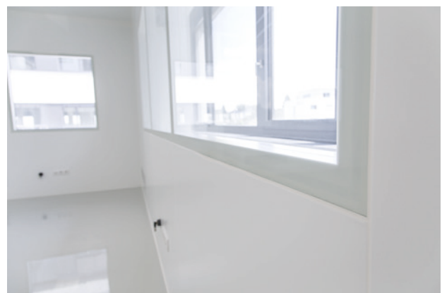
Labor- Wandsystem absolut flächenbündig mit Verglasung
